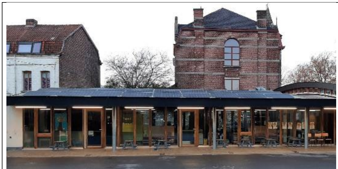
Installation photovoltaïque de l'école du Petit Colisée en 2022, 24 kW
