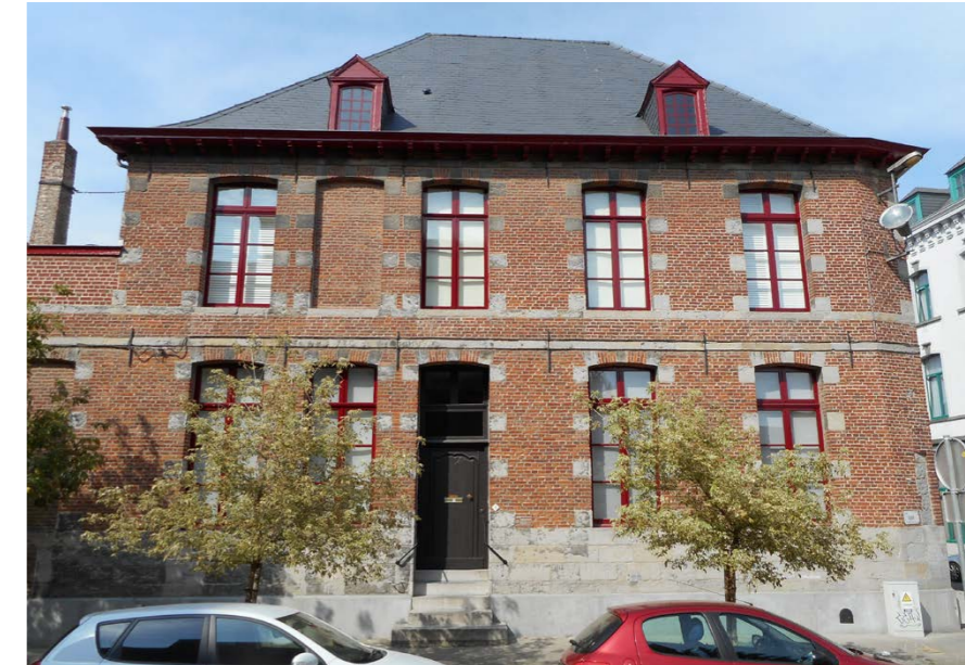
▲ Une couleur rouge assez soutenue est adaptée pour les menuiseries d'un bâtiment de style classique tournaisien.
