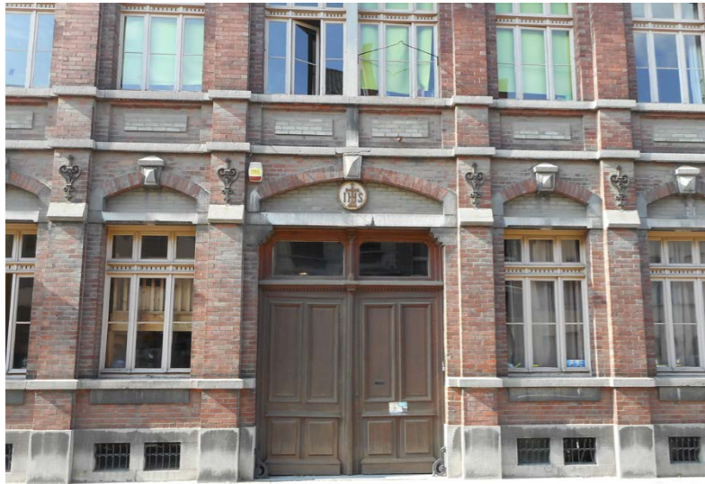
▲ Châssis de style éclectique.
