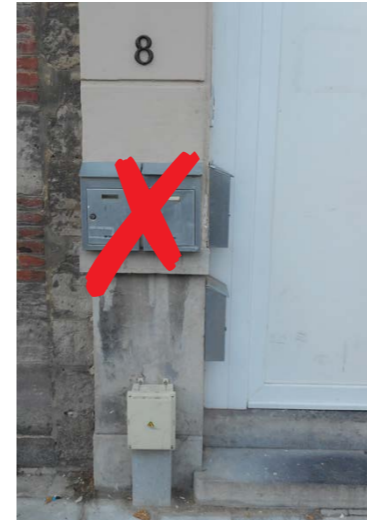
▲ Exemples de boîtes aux lettres mal positionnées, de teinte ou matériau inadaptés.
