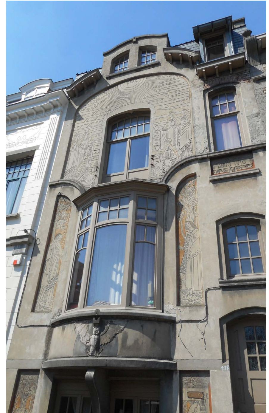
▲ Façade cimentée et ornée de décors gravés et peints.
