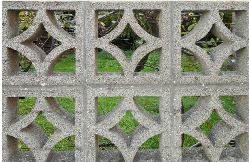
▲ Claustra en béton.
