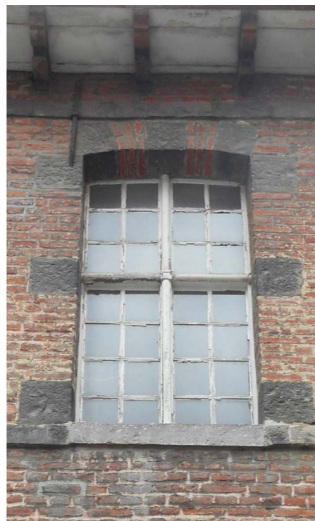
◀ Châssis en bois à croisée au profil en demi rond et petits bois, dans le style caractéristique de la première moitié du XVIII e siècle.
