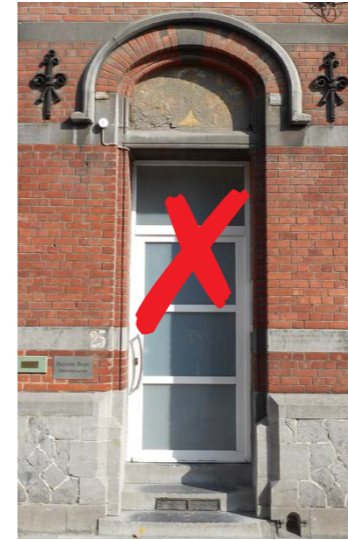
▲ Modèles de portes partiellement vitrées, inappropriés avec l'architecture de la façade.
