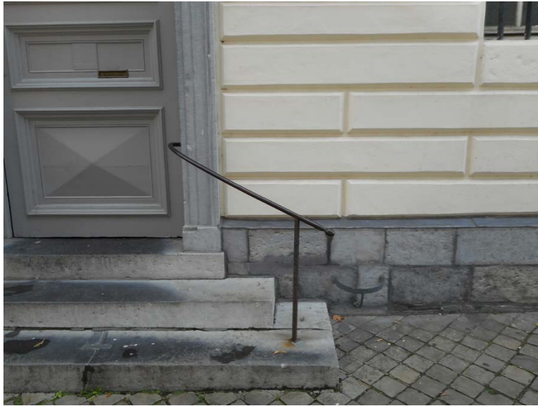
▲ Main courante et décrottoir en ferronnerie
