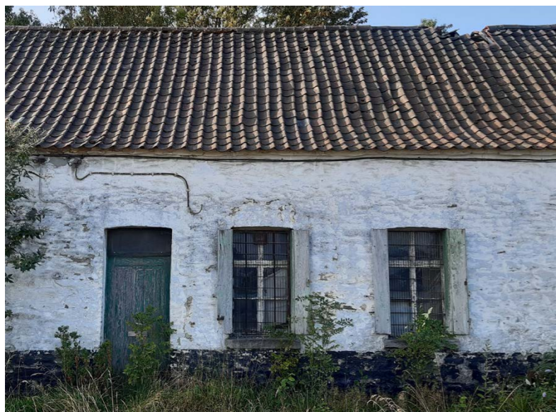
▲ Moellons de pierre chaulés et couverture de tuiles en « S » (pannes).
